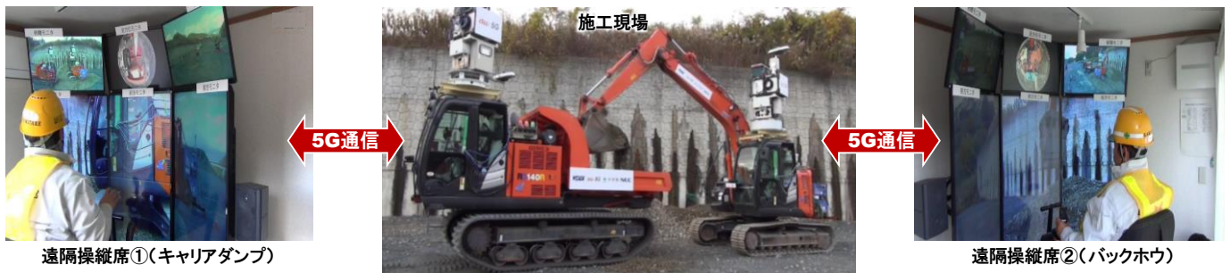
図1 5G通信を用いた重機の遠隔操縦イメージ(災害復旧を想定した例)
