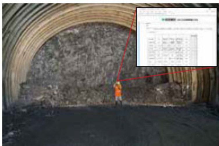
坑内での使用状況
