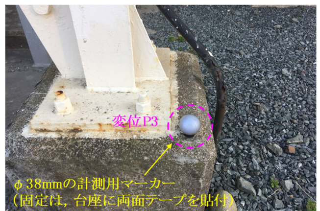
基礎に貼り付けたマーカー
