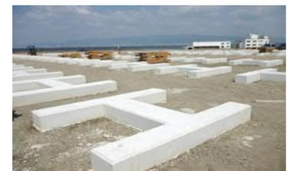
図11 メガソーラー基礎への適用
