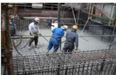
図6 クリーンクリートの打設状況
