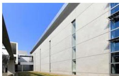
図7 建物外壁のクリーンクリート
