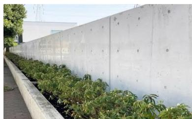
図10 現場打ち鉄筋コンクリート(RC)壁
