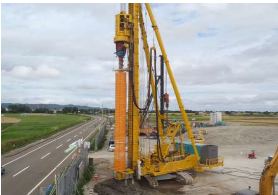
施工状況 (S-MIX)
