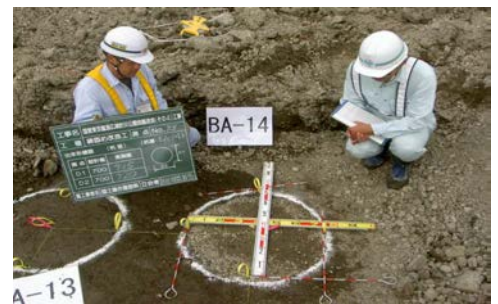
出来形杭径確認
