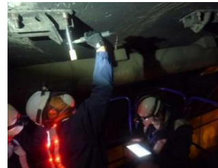
吊り下げボルト測定状況
