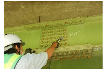
添接部F11Tボルト測定状況
