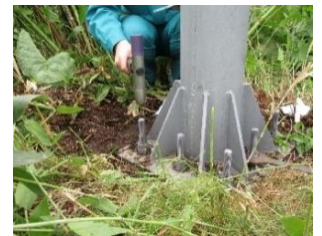
アンカーボルト測定状況
