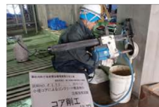
コア削工状況
