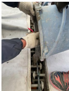
写真2 間詰材打設の様子
