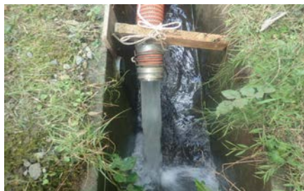
図5: 排出水確認 洗浄7回目
