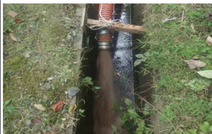
図4: 排出水確認 洗浄1回目
