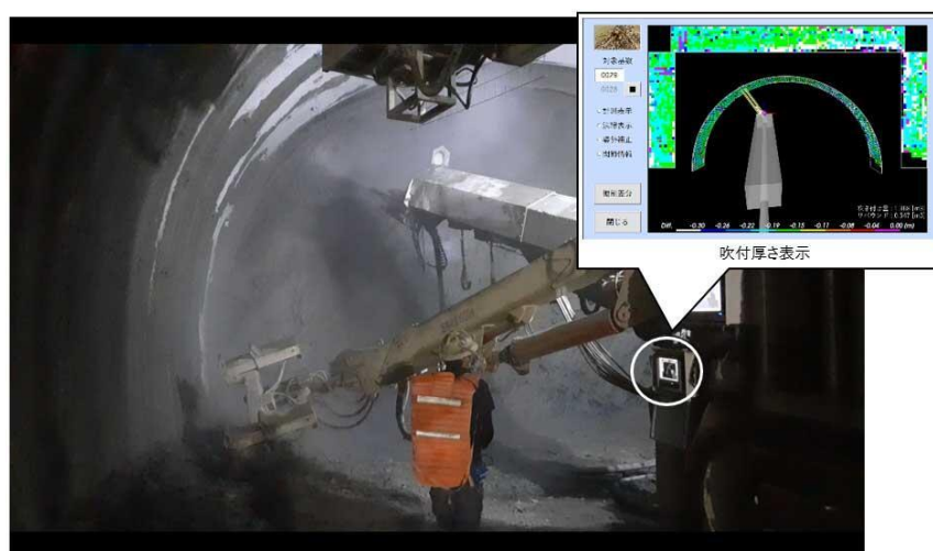
リアルタイム吹付出来形表示
