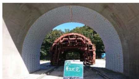
打設完了・養生・モニタリング
