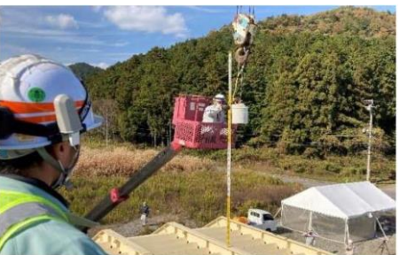
落下荷重載荷試験
