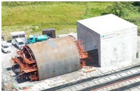
再生覆工コンクリート試験全景
