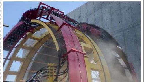
既設覆工切削状況
