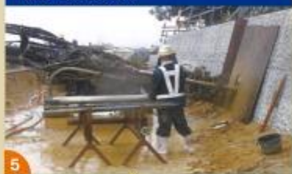
剛孔→補強鉄筋挿入
