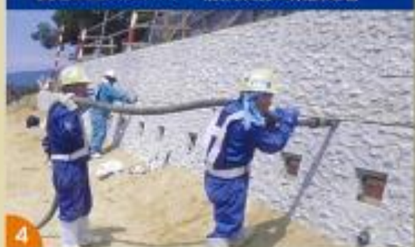
裏込め注入グラウト→補強鉄筋の緊張定着
