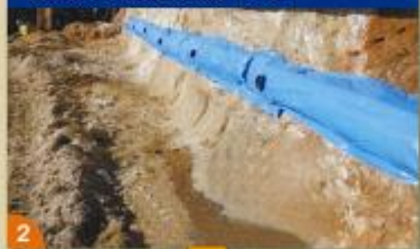
2段目パネル背面排水材設置状況
