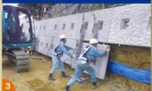
下段パネル設置状況
