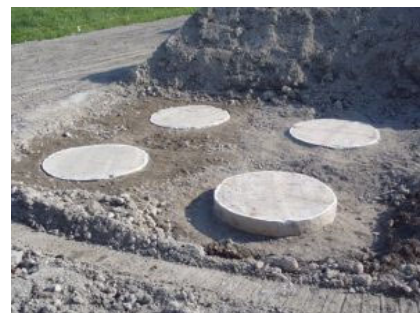
出来型杭径確認
