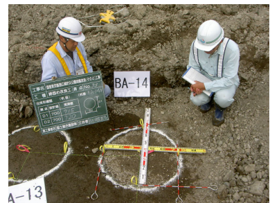
出来型杭径確認
