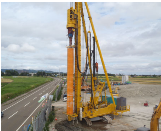
施工状況(KS-S・MIX)
