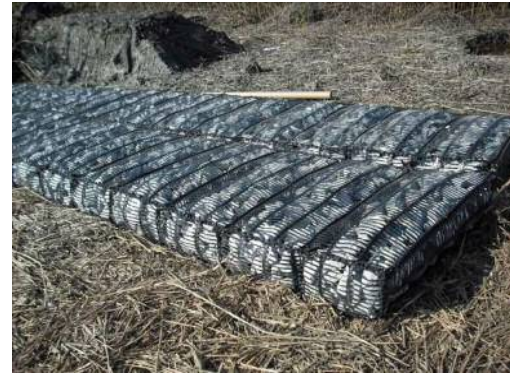
中詰材充填後
