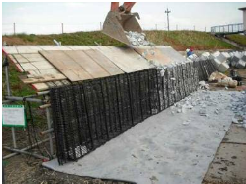
中詰材充填用架台、中詰材充填
