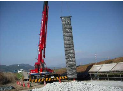
吊上げ状況 《片吊り》
