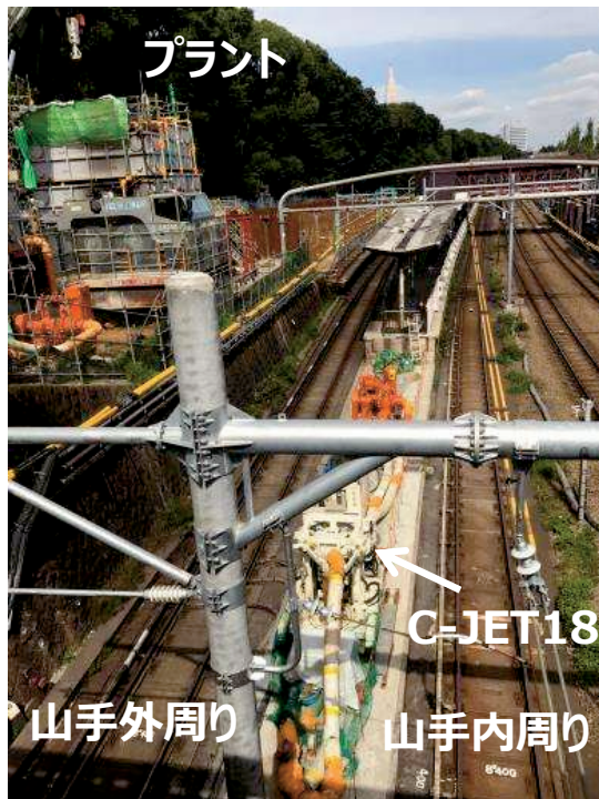
施工箇所全景
