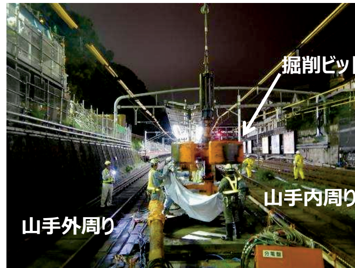
掘削ビット投入状況
