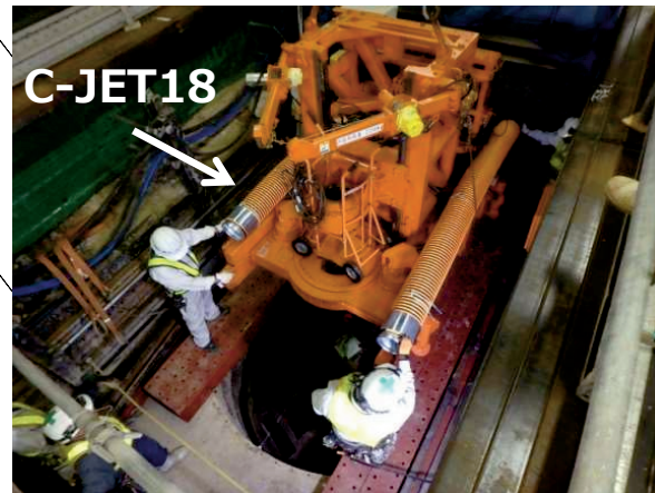
掘削機設置状況
