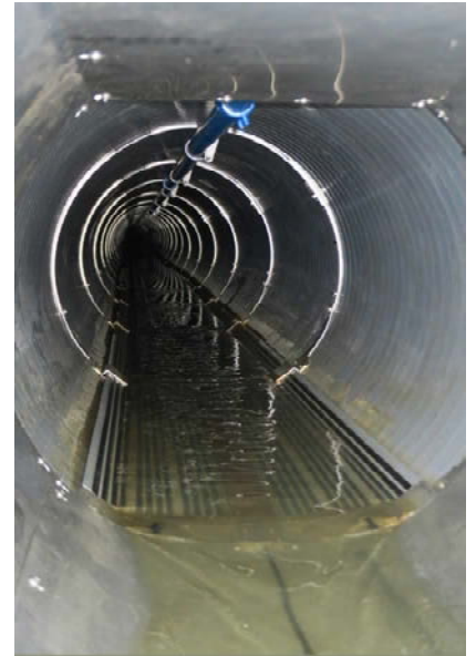
図-2 下水熱利用システム (採熱部の施工例)
