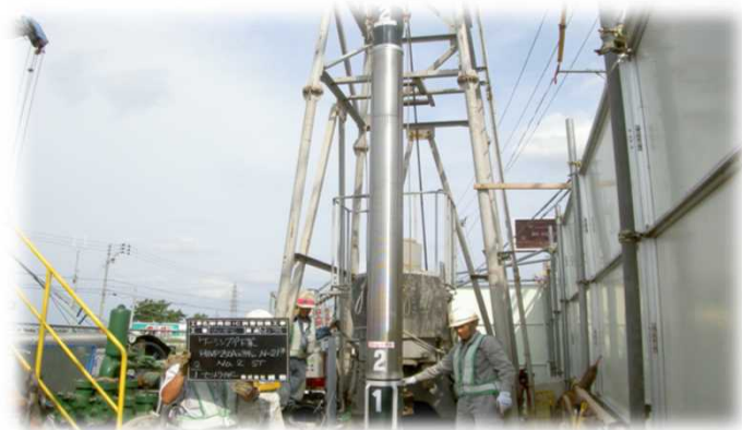
図3 KVSストレーナの設置(施工)例 活用件数推移
