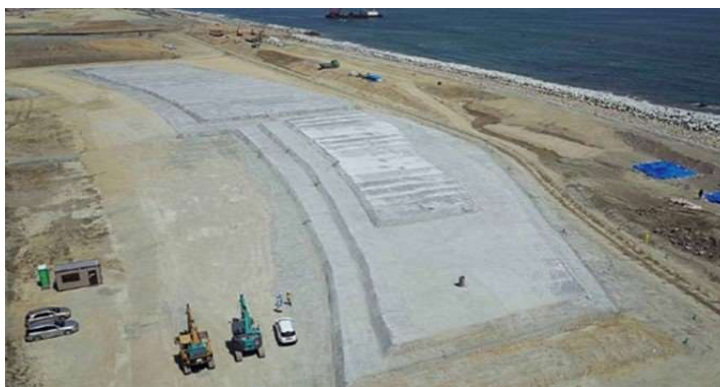
盛土材(造成工事)
