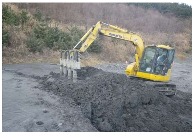
製造状況(振動締固め)
