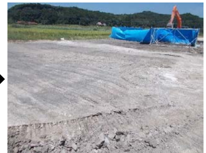
改良土(転圧後)
