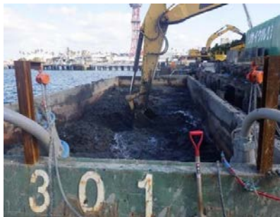
浚渫土荷揚げ
