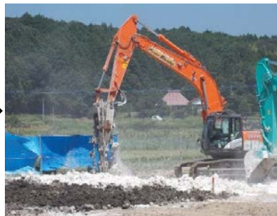
パワーブレンダーによる混合
