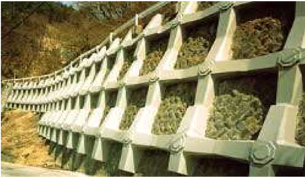
PCフレームアンカー工法
