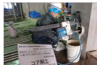
コア削工状況
