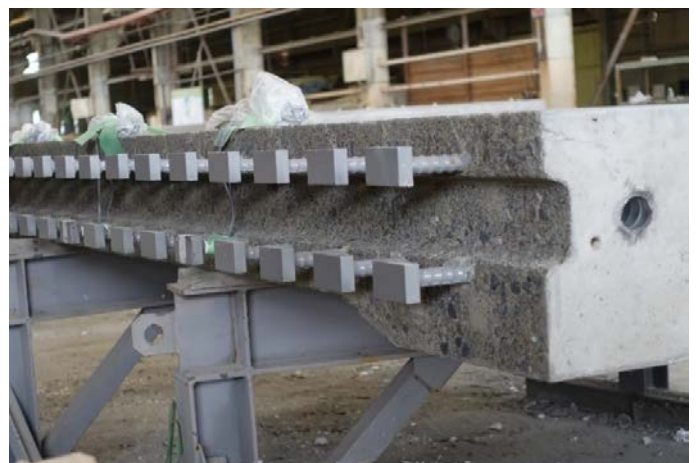
接合部配筋状況
