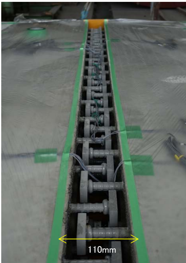
接合部配筋状況
