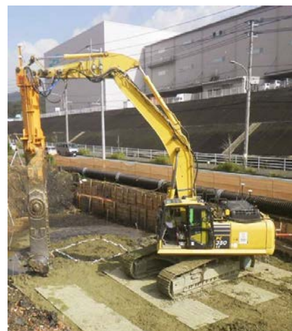
WILL-i工法 施工状況
