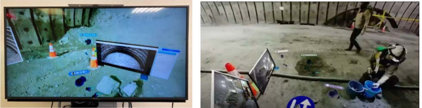
【3Dモデルに取り込んだ情報をもとに工事進捗をバーチャルで確認している状況(発注者・現場監督など)】
