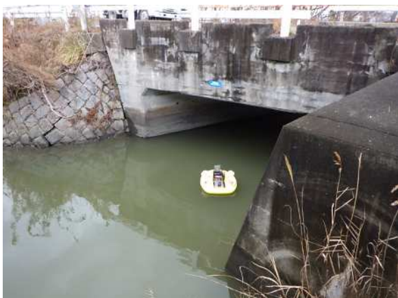
(e)現場状況その3
