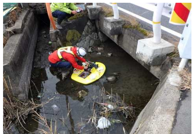
(f)現場状況その4
