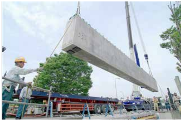
プレストレストコンクリート桁の架設状況
