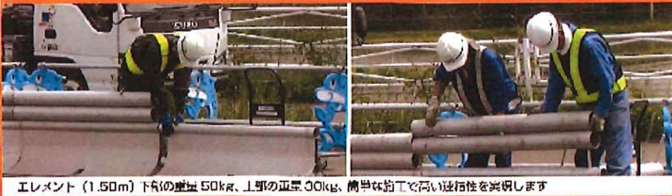
エレメント (1.50m) 下部の重量 50kg、上部の重量 30kg、橋上での高い操作性を实験します
