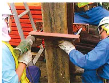
H形鋼支柱への取り付け状況
