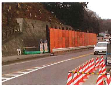
パネル式防護柵の設置状況
