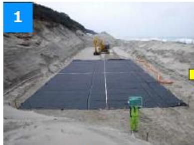
1 床掘り・整地・洗掘対策
