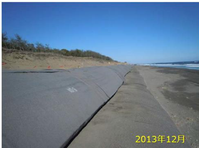
写真1：ジオチューブDS設置
