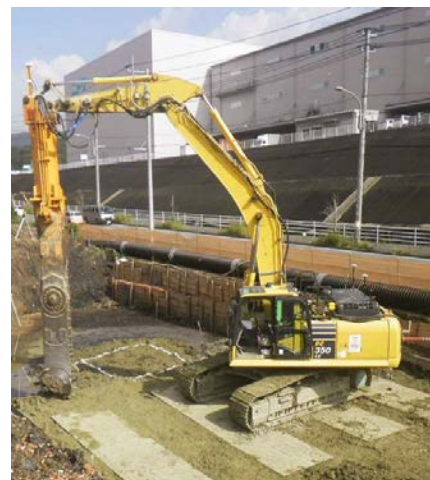
WILL-i工法 施工状況
