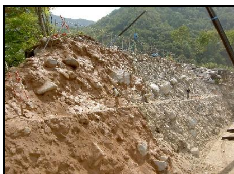
写真-3 仮設吹付工実施状況
