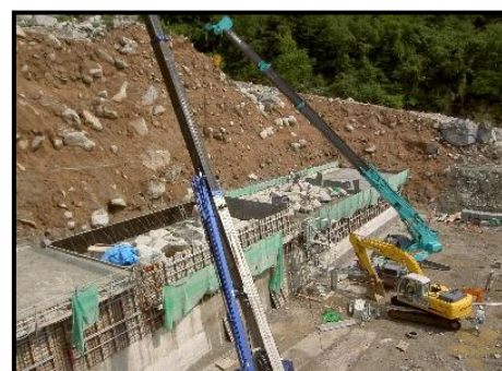
写真-4 本施工実施状況
