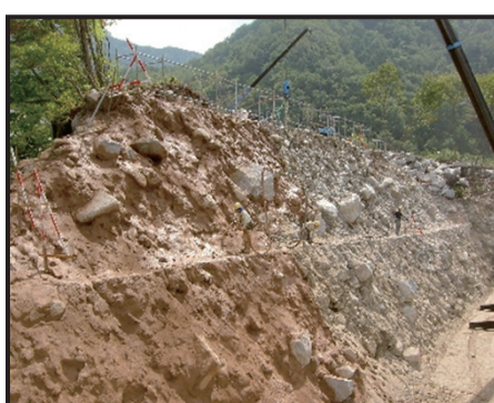
仮設吹付工実施状況
