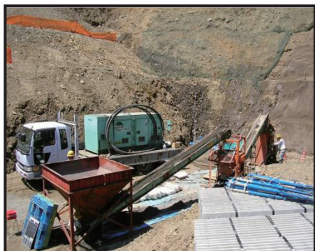
施工プラント
