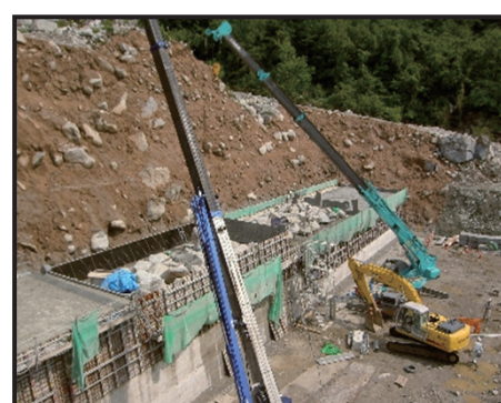
本施工実施状況
