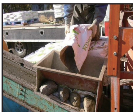
ECOバインド及び骨材（砂）投入
