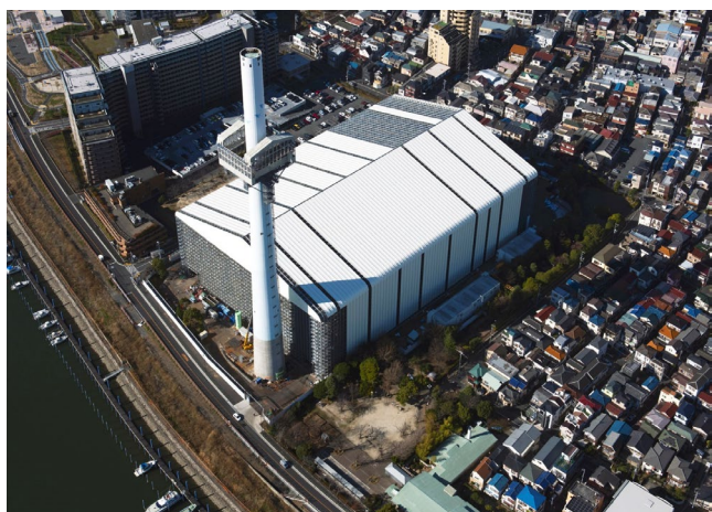
3 両妻面鉄骨を組み立てて、屋根、壁シートを取付ける。
