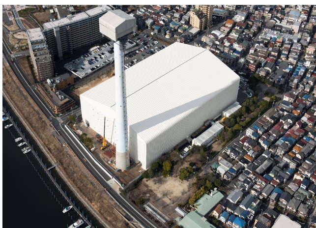
4 テント内の負圧化により工場棟・焼却設備の解体を行う。
