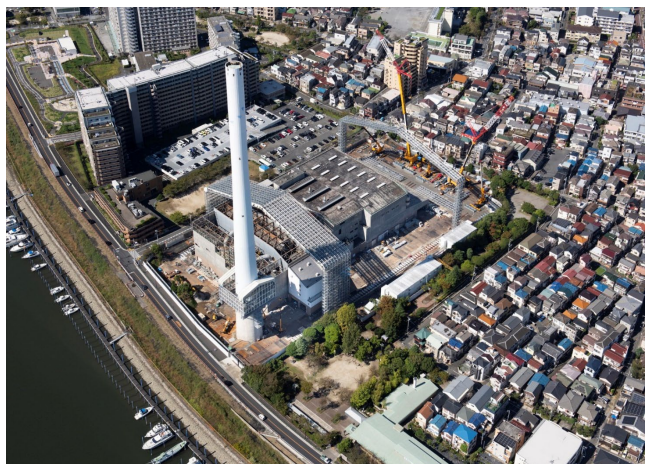
1 工場奥のエリアで鉄骨を組み立てて煙突側へ送り出す。
