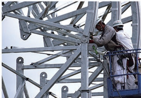
■ ユニットピン接合組立 (モックアップ時)
