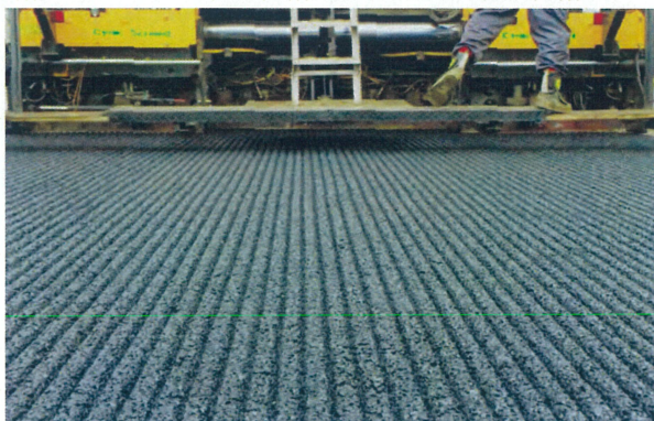
舗装表面(縦溝粗面)の仕上がり
