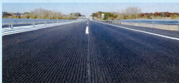
縦溝粗面仕上げ路面の例
