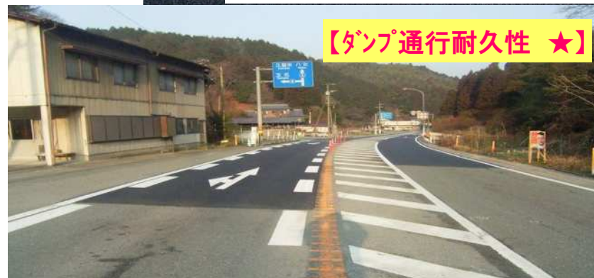
国道3号 久留米管内維持工事(福岡県八女市 H24.12)
