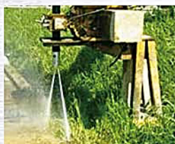
▲障害物削孔高圧噴射
