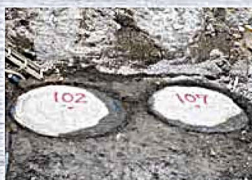
▲改良体出来形
