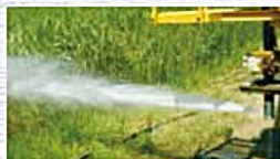
▲改良体造成中圧噴射
