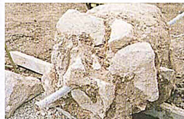
▲QSJによる障害物を巻き込んだ改良体
