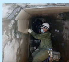
シート差込み状況
