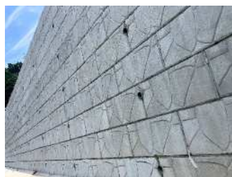
○ブロック積擁壁
