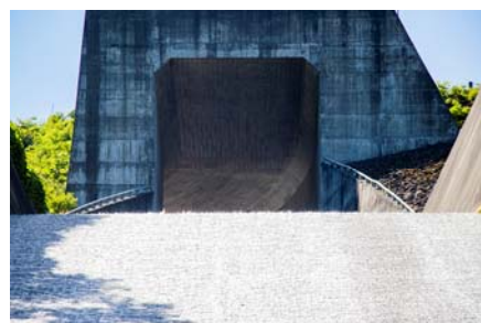
水路 下水道 トンネル
