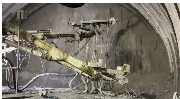
実施状況(吹付機)
