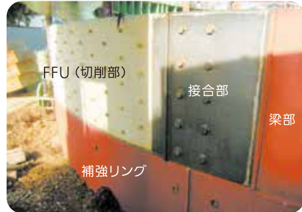
施工例：φ12.1m (品川区)
