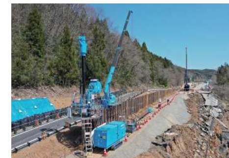
擁壁・土留め
