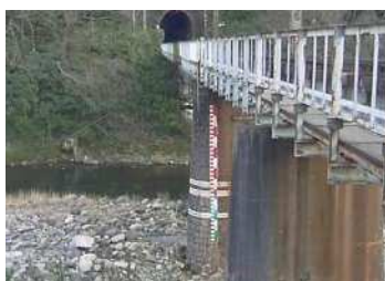
鉄道橋脚を監視したWebカメラ画像
