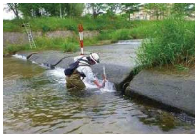
河川構造物の点検
