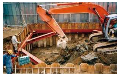
浄化(汚染範囲掘削除去工事)
