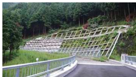
のり面対策工
