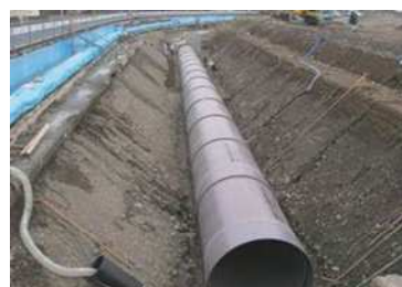
農業水利施設
