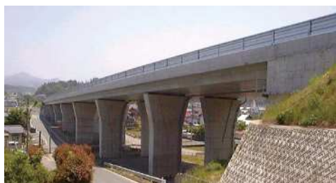
橋梁・高架橋
