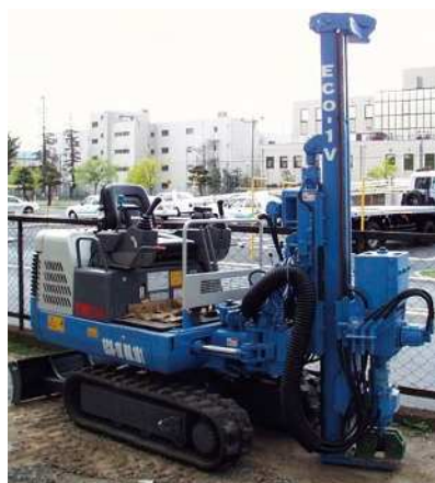
調査(打撃・振動貫入機械によるサンプリング)
