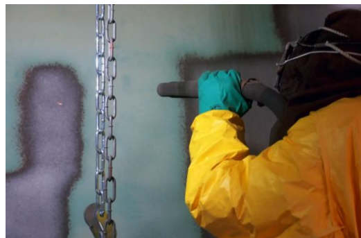
循環式プラスト施工状況
