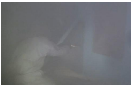
非循環型プラスト施工状況
