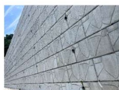
○ブロック積擁壁
