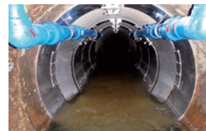
ヘッダー部設置状況
