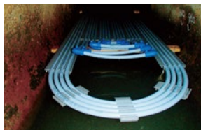
採熱管設置状況
