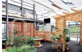
施設内ヒートポンプ 設置状況
