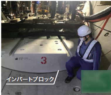
千葉印西エリア洞道新設工事(その2) 発注者: 東京電力パワーグリッド(株)
