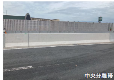
阪神高速道路 14 号松原線 喜連瓜破 - 三宅間 松 P-470 付近 試験施工 阪神高速道路(株)
