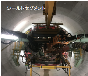
下水処理場シールドトンネル工事 発注者: 海老江ウォーターリンク(株)
