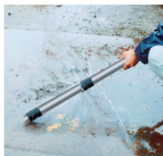
加圧注入状況(清水にて噴射)
