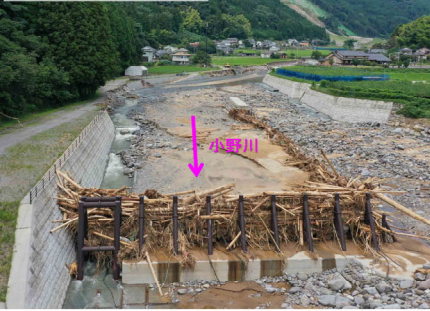
捕捉工の正面より撮影
