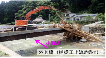
外其橋（捕捉工上流約2km） 捕捉工上流側の橋梁地点における流木の撤去作業状況
